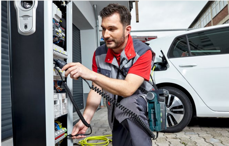
Prüfen der elektrischen Sicherheit mit PROFITEST MXTRA (GOSSEN METRAWATT)
